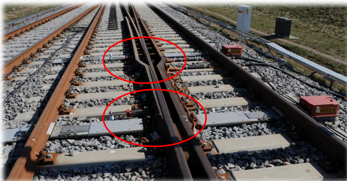
Eksempel på aflåsning af de to drev ved den bevægelige hertespids.
